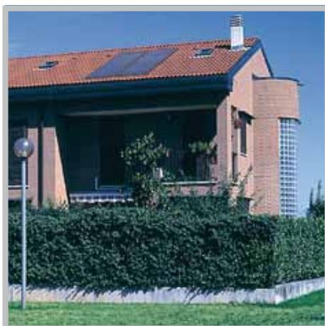
Пример монтажа на наклонной крыше
